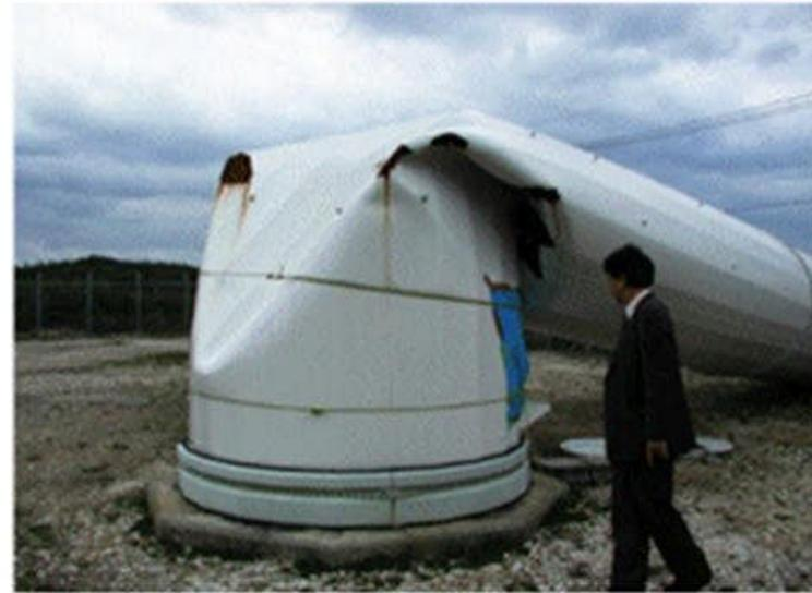
写真:台風被害を受けた宮古島の風力発電機(2003年9月 台風14号)
