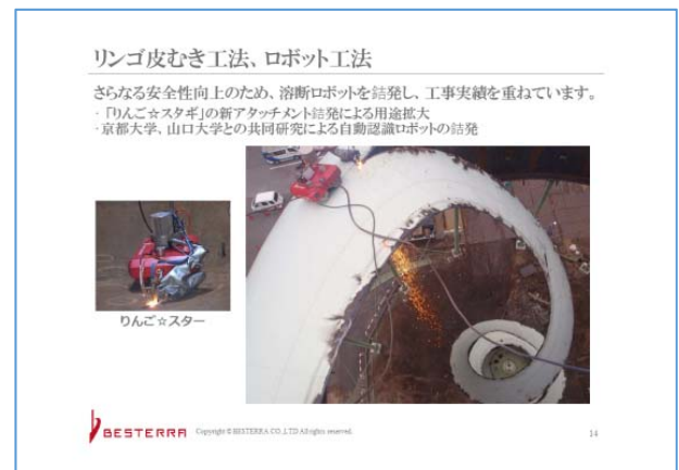
図 3 リンゴ皮むき工法、講演資料より
